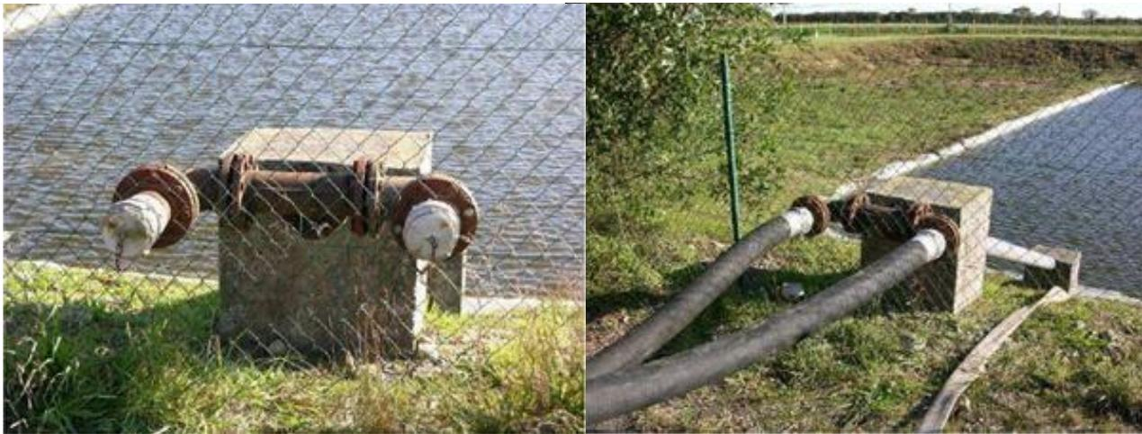
Sortie de Ø 100 mm et canalisation de Ø 150 mm sur une réserve ouverte.
