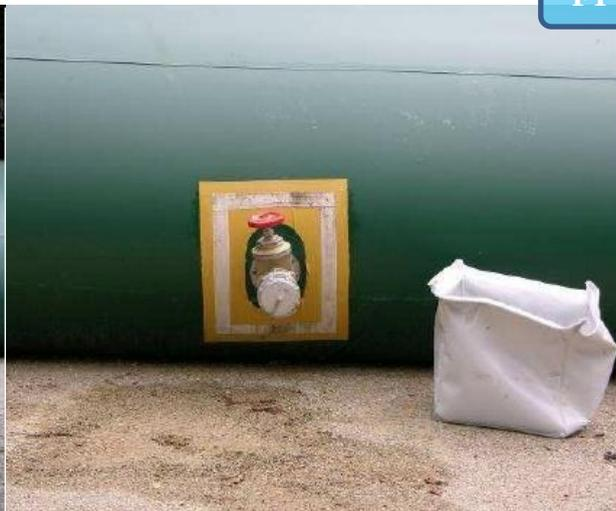
*1 prise de Ø 100 mm « sous eau » avec bouchon d'obturation vanne*
