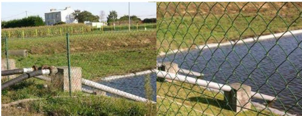
2 colonnes d'aspiration de Ø 150 mm espacés de 4 m. Chaque canalisation de Ø 150 mm est dotée de 2 sorties de Ø 100 mm équipées de bouchons.
