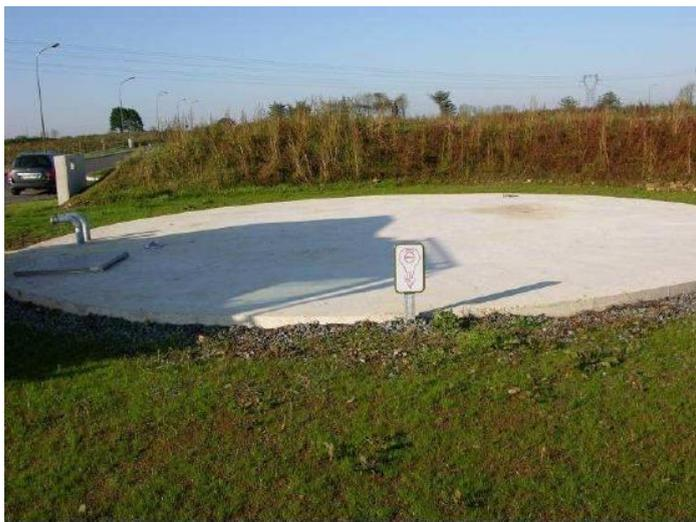
*Réserve enterrée de 240m<sup>3</sup> avec 2 sorties de Ø 100 mm, une trappe d'accès permettant également le remplissage, un évent d'aspiration ainsi que la signalisation*
