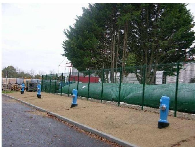
*Réserve souple avec piquage enterré et poteaux d'aspiration de Ø 150 mm*
