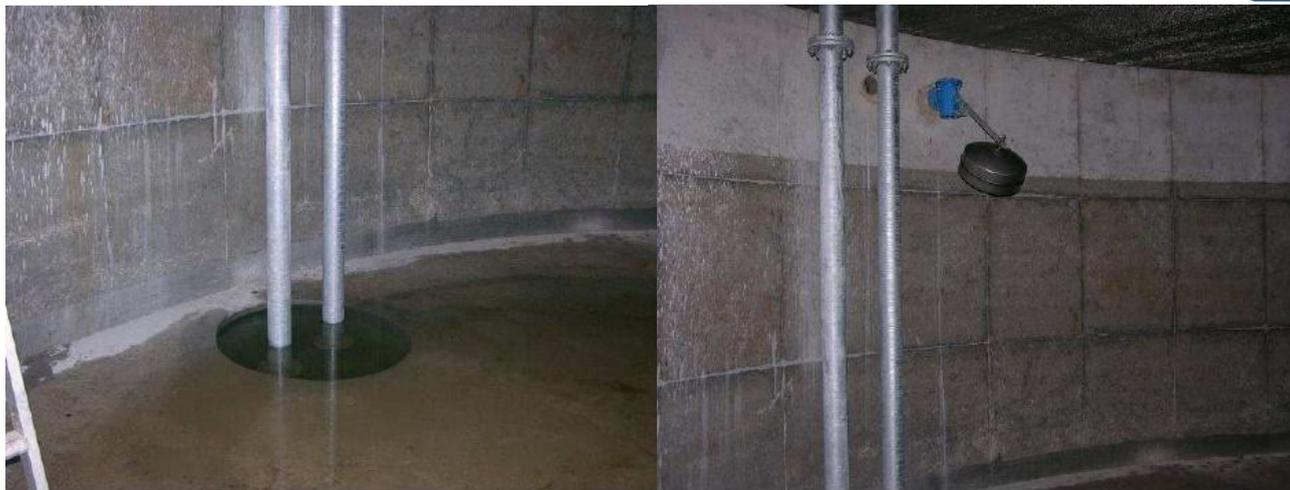
Dispositif d'aspiration totale de  $\varnothing$  100 mm dans une réserve enterrée de  $240 \text{ m}^3$ , correspond à 2 sorties de  $\varnothing$  100 mm.
